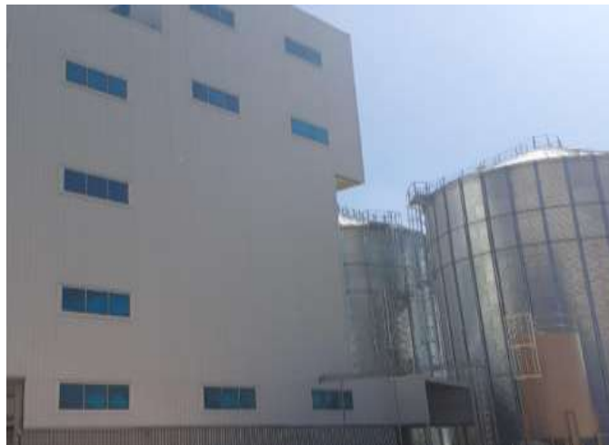
Figura 1. Vista lateral de la planta.
